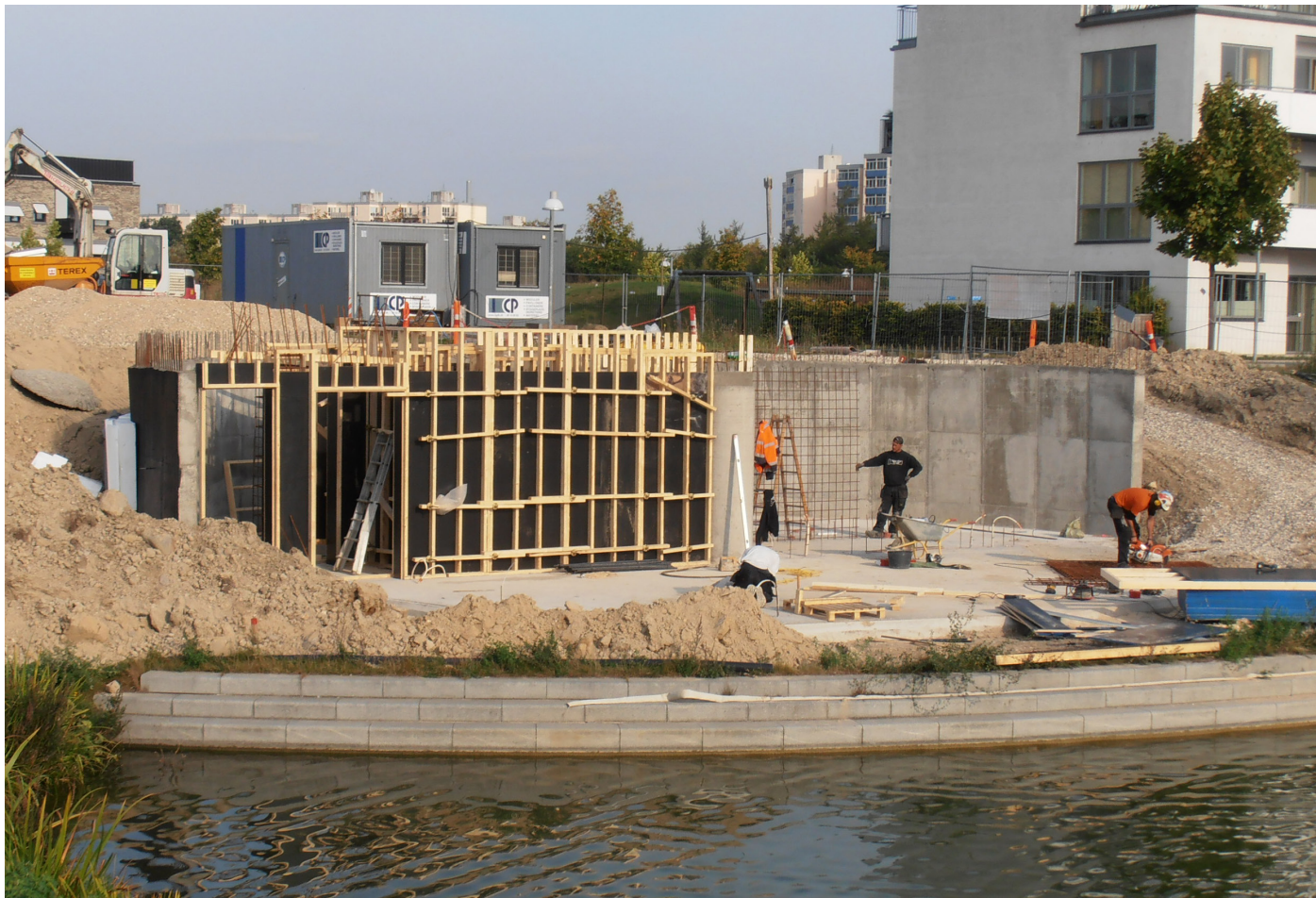
Byggeriet d. 26. september 2016.
